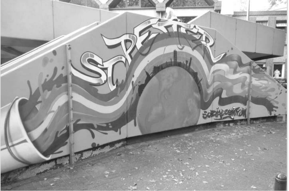
Die Wand von außen ...
