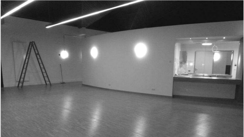
Mitten in der ehemaligen Kirche entsteht eine Küche
